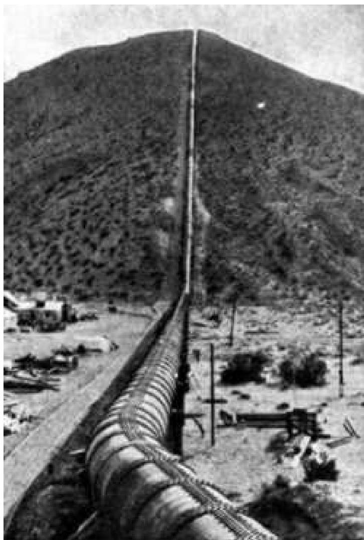
Đường ống Tidewater
